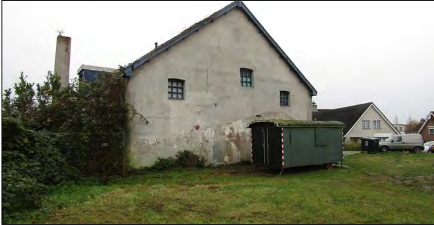
Figuur: het gebouw aan de Huizersdijk (naast het projectgebied) biedt mogelijk verblijfplaatsen aan vleermuizen in kieren en gaten, zoals onder de regenpijp en onder de betimmering van de dakkapel.
