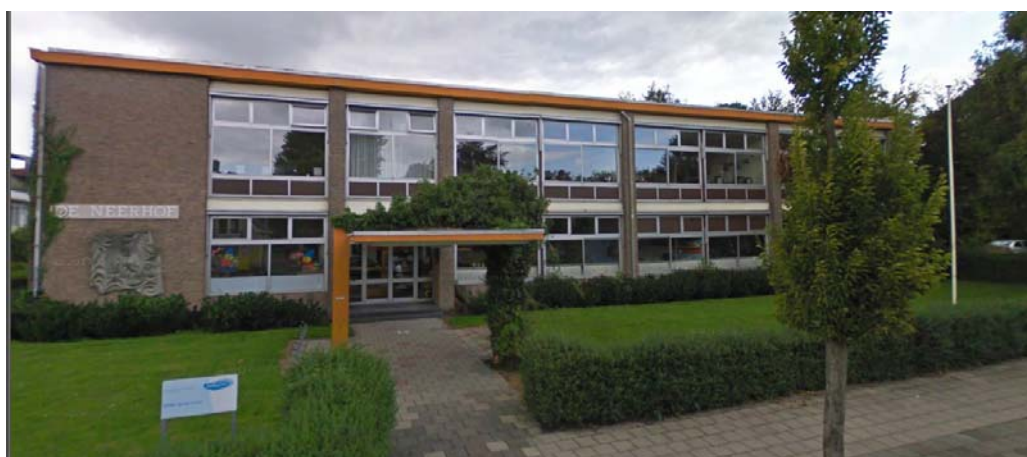
Afb 6: De te slopen bebouwing van de basisschool
