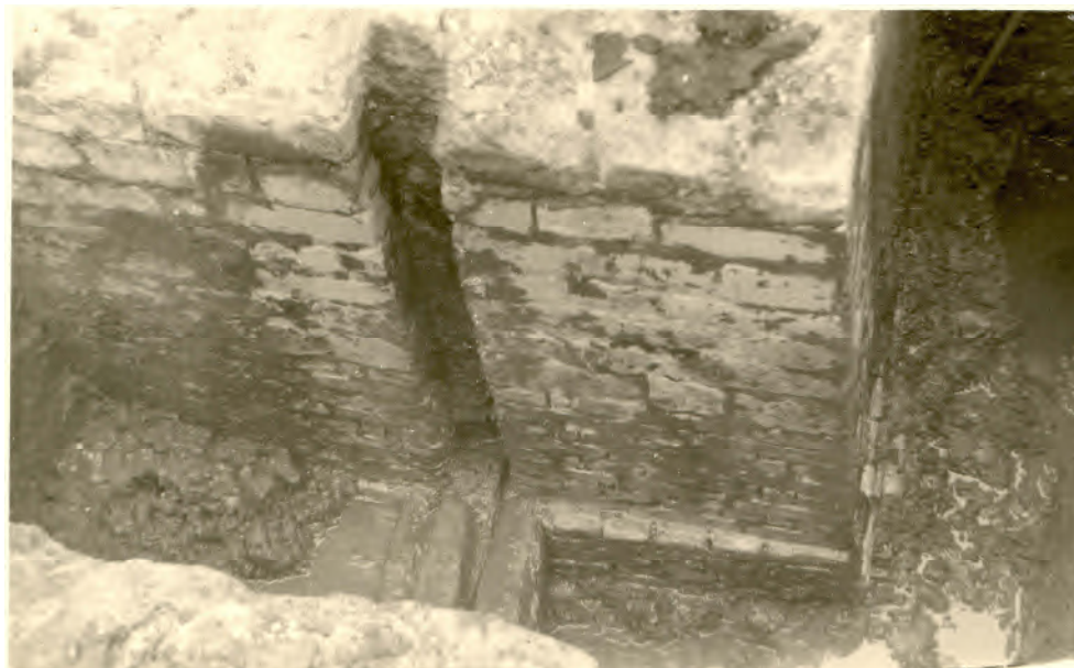
Afbeelding 12: één van de poeren met de gleuf voor de waterwerken (foto: heemkundekring Zevenbergen).
