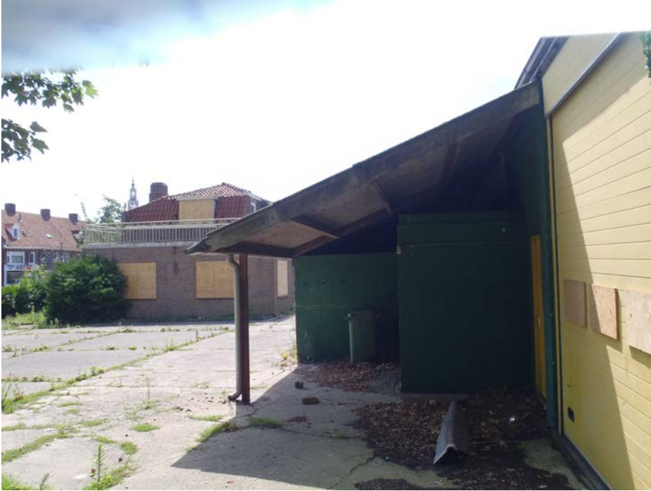
Achteraanzicht woonhuis Stooftstraat 2 en overkapping aan de bijgebouwen van het woonhuis aan de Stooftstraat 6.
