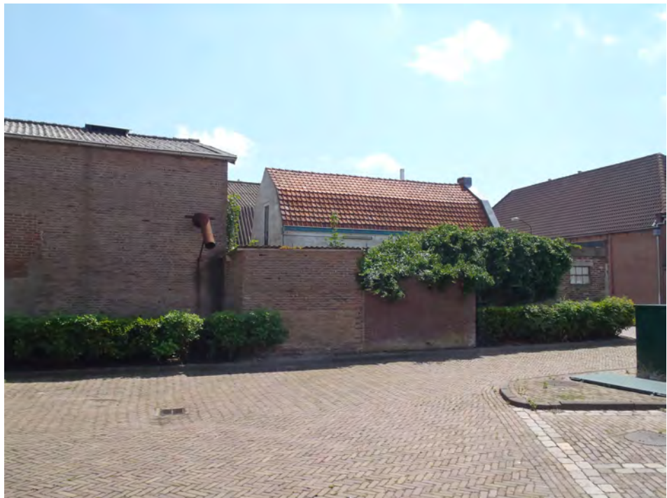
Bestrating ten behoeve van parkeerplaatsen en zijaanzicht woonhuis Stooftstraat 6 met bijgebouwen.
