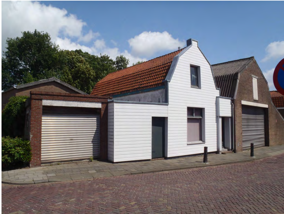
Vooraanzicht woonhuis en bijgebouwen aan de Stooftstraat 6.
